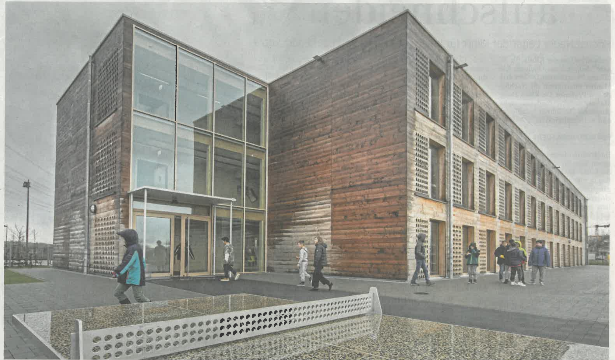
Ansprechend wirkt die Integrierte Gesamtschule (IGS) Kalbach-Riedberg aufgrund ihrer hölzernen Fassade. Und die Modulbauweise hat sich gerade bei den dringend notwendigen Neubauten als schnell und kostensparend erwiesen. Das Gebäude liegt an der Carl-Hermann-Rudloff-Allee auf dem Riedberg. Fotos: Leonhard Hamerski
